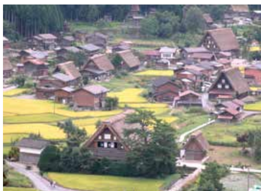
高速道路整備と駐車場マネジメントを魅力向上につなげた白川郷
