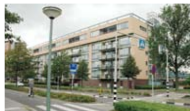
2009年に調査したオランダの改修事例
