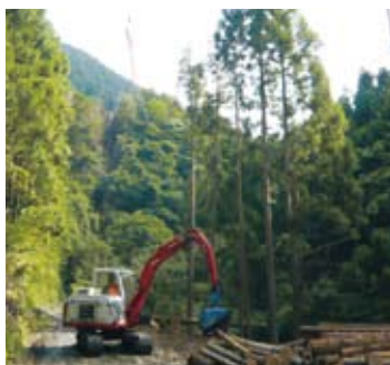
索道での運搬作業
