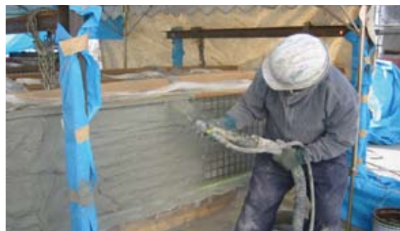
基盤コンクリートに炭素繊維格子筋を配置、引張試験を実施
